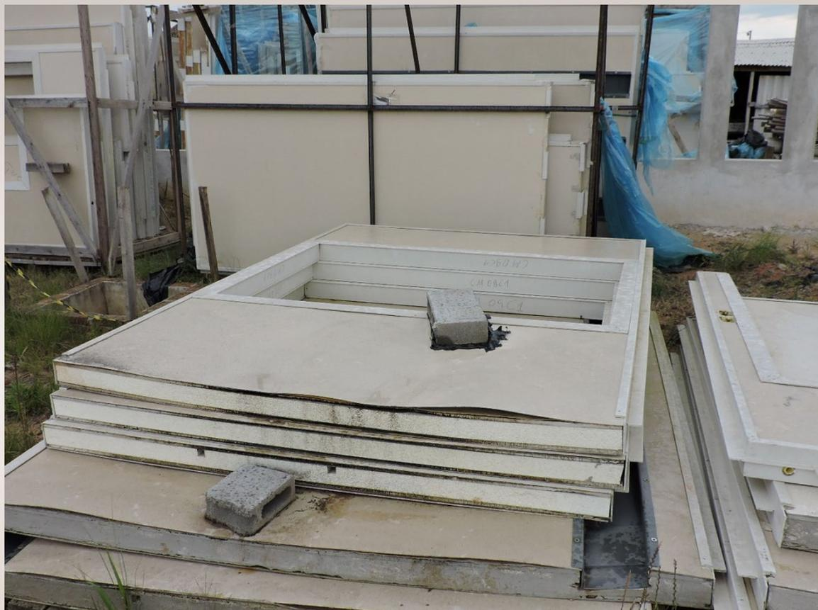
**Armazenamento inadequado de painéis e problemas nos painéis com miolo em gesso acartonado**
